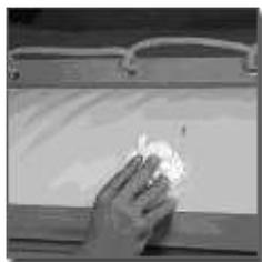
1- Limpe a superfície a ser reparada. No caso de existir qualquer agente gorduroso, lave a área com água e sabão e em seguida seque e limpe com um pouco de solvente à base de acetona (Ex.: thinner).
