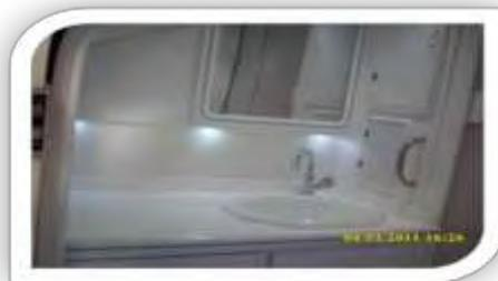
A pia e as tampas utilizadas no banheiro são de solidsurface. Material resistente a manchas, arranhões, mofo e bolores. São resistentes à umidade e maresia, higiênicos, não tóxicos, não porosos, permitem reparo e não propagam chamas. Sua limpeza deve ser com esponja macia, água e detergente neutro.
