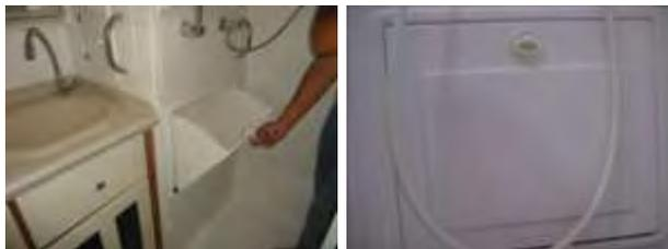
Receptáculo de detritos instalado dentro do boxe do banheiro
