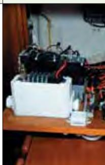
A instalação é benfeita, com fios estanhados. O quadro elétrico fica bem localizado, acima da mesa de navegação. A chave geral é bem protegida e visível, abaixo desta mesa. A bateria fica em um paiol debaixo do sofá no salão e é bem presa.
